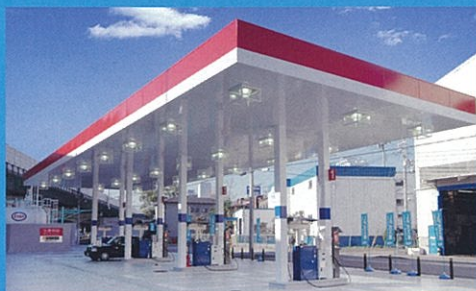
LPガスとガソリン両方を扱うエコ・ステーション
